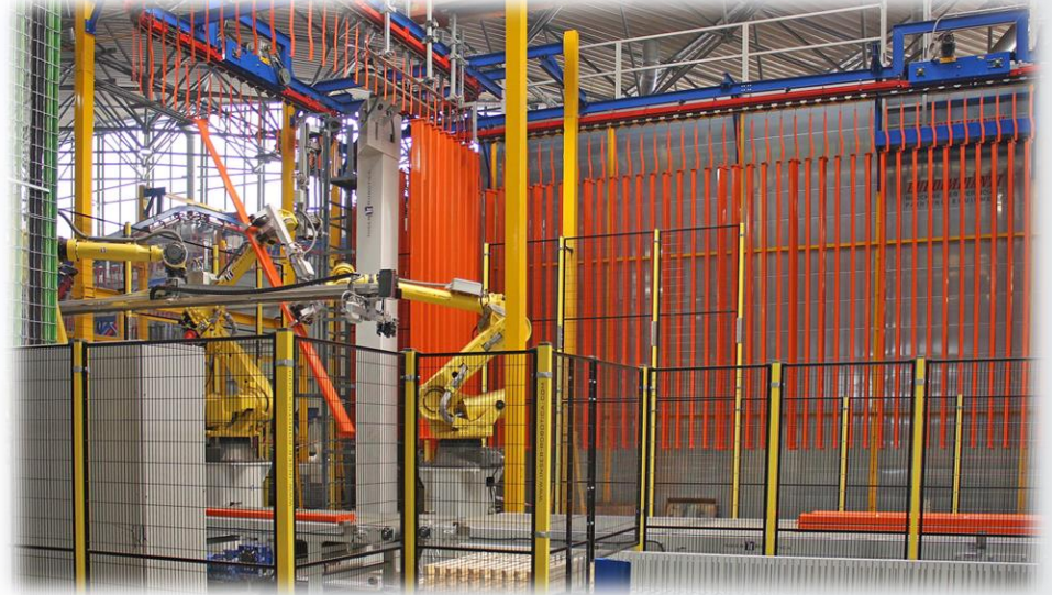
Cadena de pintura robotizada.
